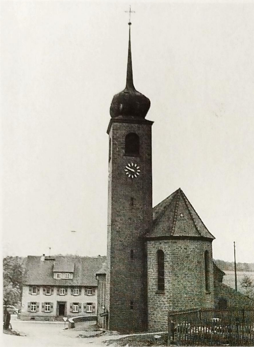
Die neu erbaute Kirche
