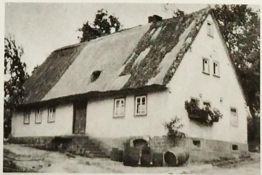
Ebenerdiges, strohgedecktes Odenwälder Einheitshaus (Repro wie oben)
